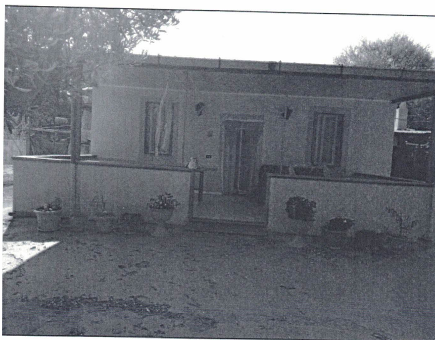
Foto secondo manufatto abusivo
