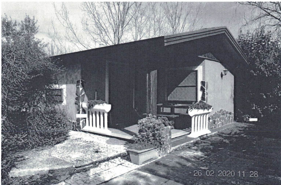
Foto manufatto abusivo
