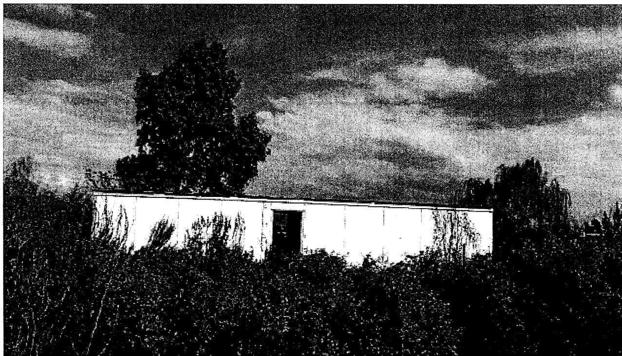
Foto secondo manufatto abusivo
